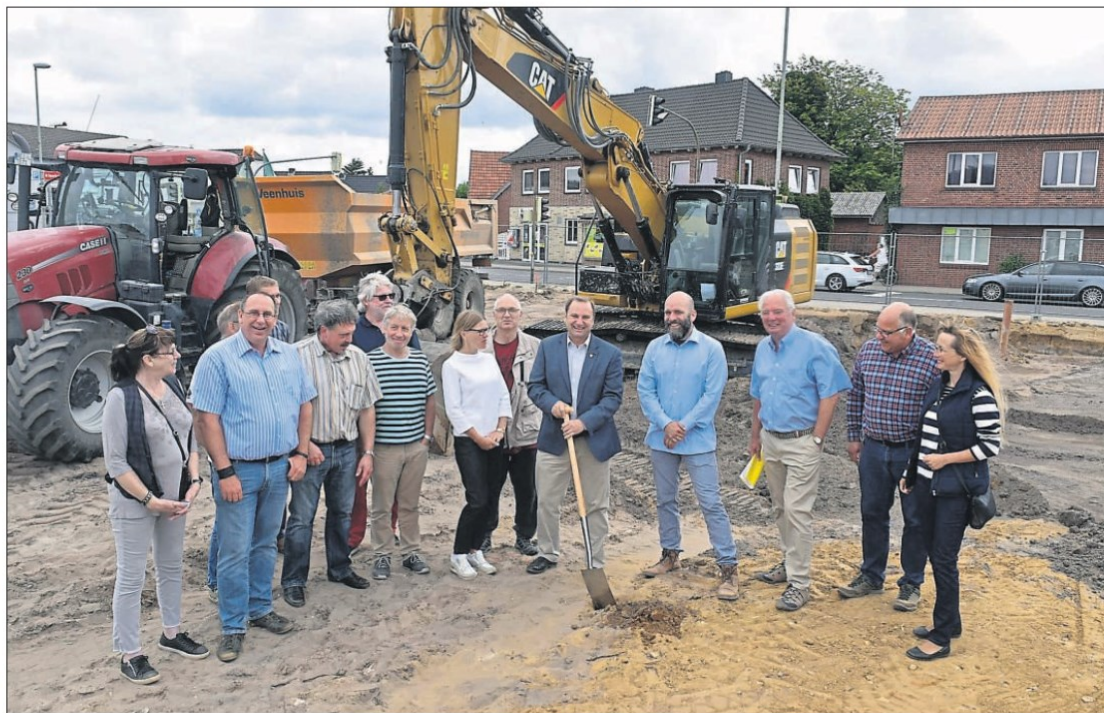
Begleitet von zahlreichen Donner Gemeindevertretern, macht Bürgermeister Volker Nielsen (Mitte) den ersten Spatenstich für das neue Multifunktionsgebäude. Rechts neben ihm Architekt Ole Jebens. Foto: Lotze
